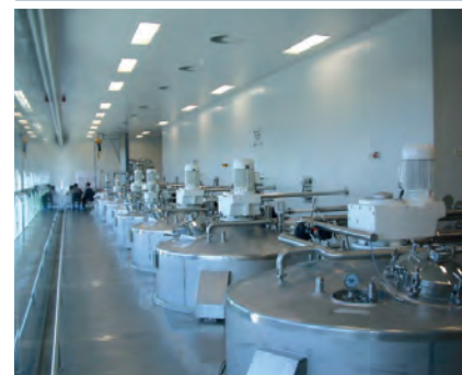
Traitement sur site
